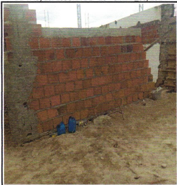
FOTO - 22 VERGA PRÉ-MOLDADA COM ATÉ 1,5 M DE VÃO, ESPESSURA DE *20* CM.AF 03/2024
