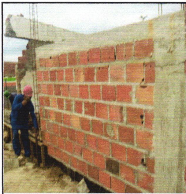
FOTO- 24 ALVENARIA DE VEDAÇÃO DE BLOCOS CERÂMICOS FURADOS NA HORIZONTAL DE 9X19X19
