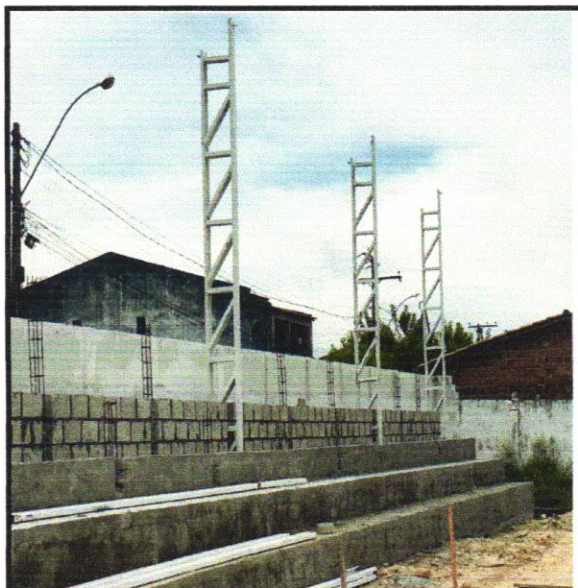
FOTO - 04: ESTRUTURA TRELIÇADA DE COBERTURA;
